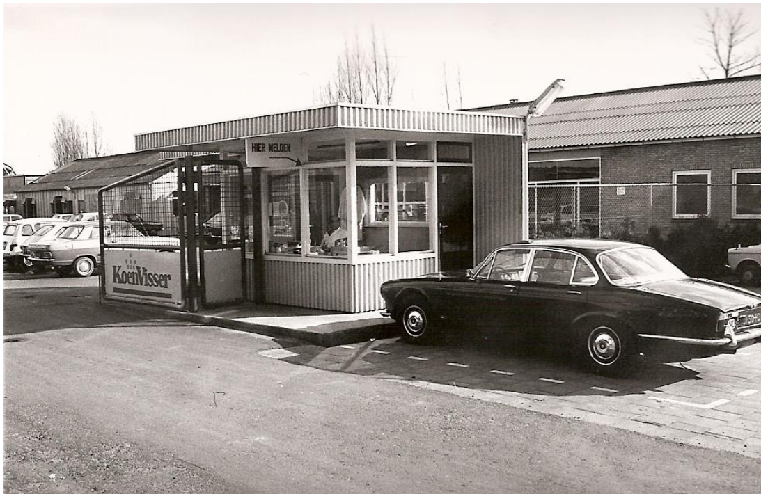
De nieuwe portierslogé met daarachter de nieuwe kantine.
