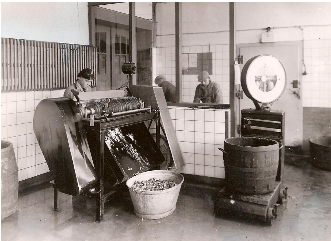
Vissnijmachine voor het op lengte snijden van vissoorten.
